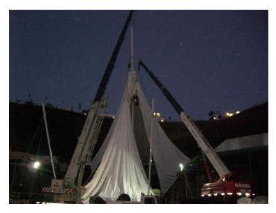
O 4o e 5o dias foram utilizados para tensionar os vértices que foi feita com o cuidado de monitorar as tensões de retesamento obtidas em projeto, através de macacos hidráulicos.
